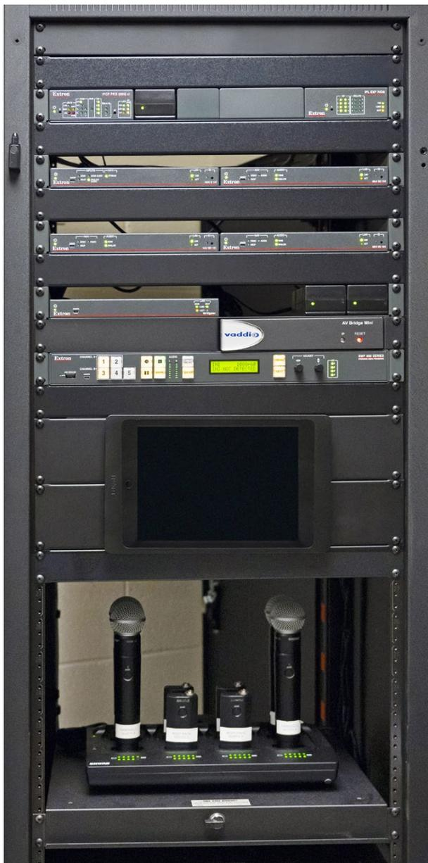
AV-Rack. Von oben nach unten: IPCP Pro-Steuerprozessoren, NAV Pro-Kodierer und -Decoder, NAVigator, SMP 352-Prozessor für Medienstreaming sowie iPad und kabellose Mikrofone auf Ladestationen.
