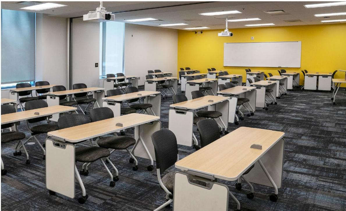
Teilbarer Klassenraum mit 60 Sitzplätzen. Das AV-System besteht aus zwei Projektoren, kabelgebundenen und kabellosen Mikrofonen, zwei ShareLink Pro-Gateways für Präsentationen, einem XPA Ultra-Verstärker mit zwei Kanälen für acht Flat Field-Deckenlautsprecher, einer DTP CrossPoint®-Kreuzschiene, DTP AV-Signalverteilung und einem wandmontierten TouchLink Pro-Touchpanel zur Steuerung der AV-Geräte in beiden Teilen des Raums mithilfe von zwei Steuerungsprozessoren der IPCP Pro-Serie.
