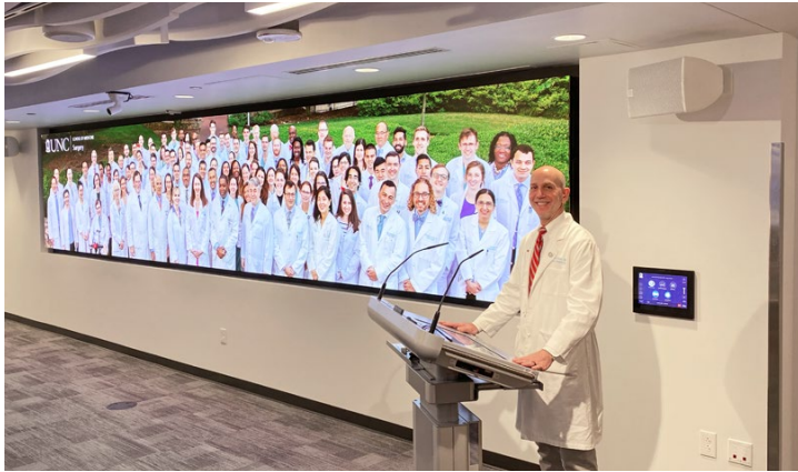
Il sistema AV e l'illuminazione ambientale sono controllati sul touchpanel TouchLink Pro montato a parete. I relatori scorrono e inseriscono annotazioni sulle slide della presentazione dal podio smart. Foto per gentile concessione di Heidi Grassley, ClarkPowell.
