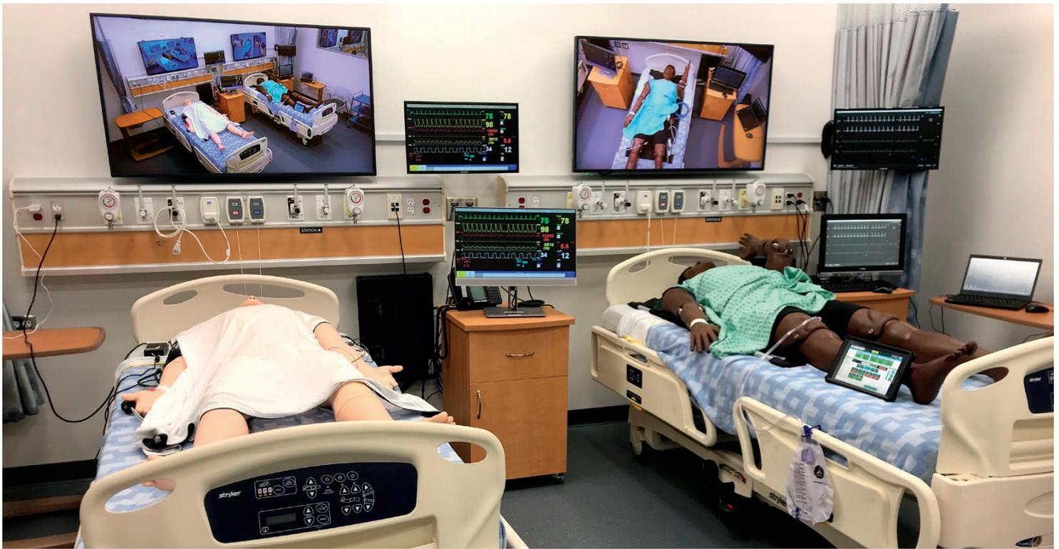
Les entrées HDMI placées sur la tête de lit et le mur offrent une connectivité audiovisuelle pour le simulateur de patient, les équipements médicaux, les ordinateurs, et les sources mobiles. Les encodeurs NAV E 101 sont alimentés via PoE+, libérant ainsi des prises électriques pour ces équipements standard de la station.
