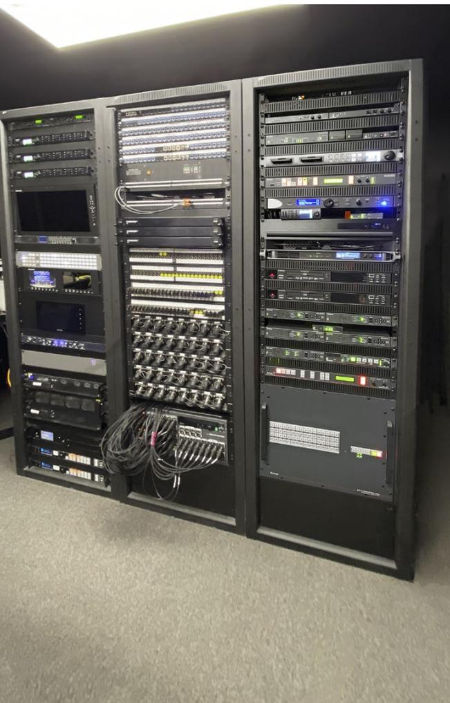
Die AV-Systemkomponenten des Auditoriums, wie z. B. die Extron XTP II CrossPoint®-Kreuzschiene, der Multi-Fenster-Prozessor und Prozessor mit dualer Aufzeichnung für Medienstreaming, wurden praktisch in einem Rack im Steuerungsraum eingebaut.
