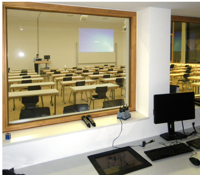
Il sistema AV dell'auditorium può essere controllato dalla parte anteriore dell'aula o dalla sala di controllo.
