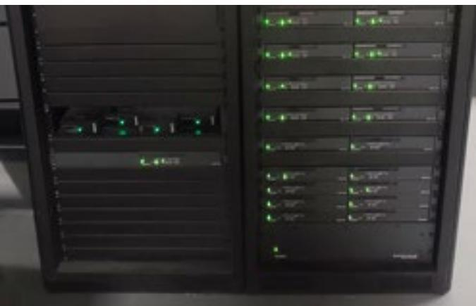
Für den Betrieb der Videowand im Krisenraum sendet die FOX3-Kreuzschiene 4K HDMI-Inhalte zum Quantum Ultra-Videowandprozessor in demselben Rack.
