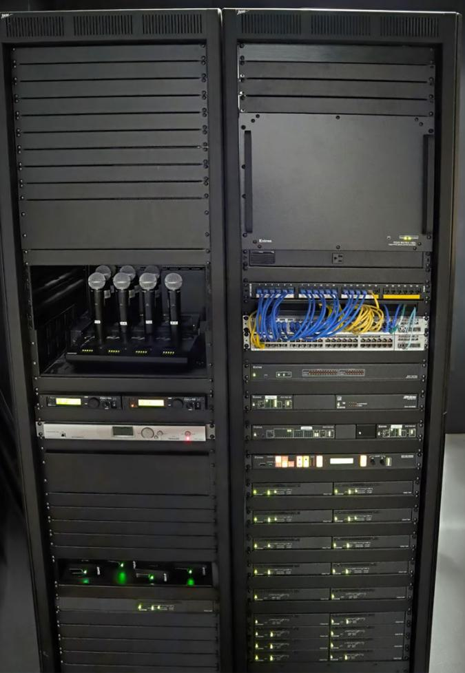
In den Racks im Technikraum neben dem Leitstand befinden sich verschiedene Quellen und die Video-, Audio-, Streaming- und Steuerungsprodukte von Extron.
