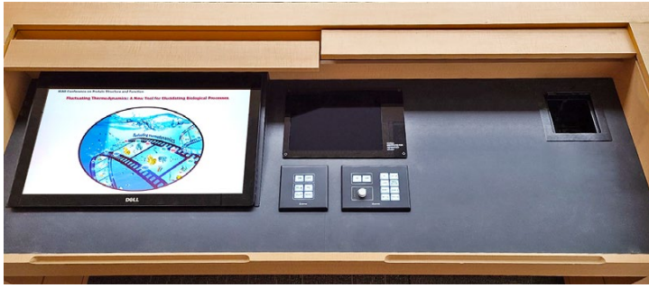
Das Pult. Tastenfelder und eine interaktive Touchpanel-Benutzeroberfläche auf einem iPad bilden die AV-Nutzerschnittstelle des Videokonferenz-Systems. Das Display des Pult-PCs befindet sich links. Ein Gäste-Laptop kann über ein Ethernet-Kabel im Ablagefach oben rechts angeschlossen werden. Foto mit freundlicher Genehmigung von Neuroo Digitech.
