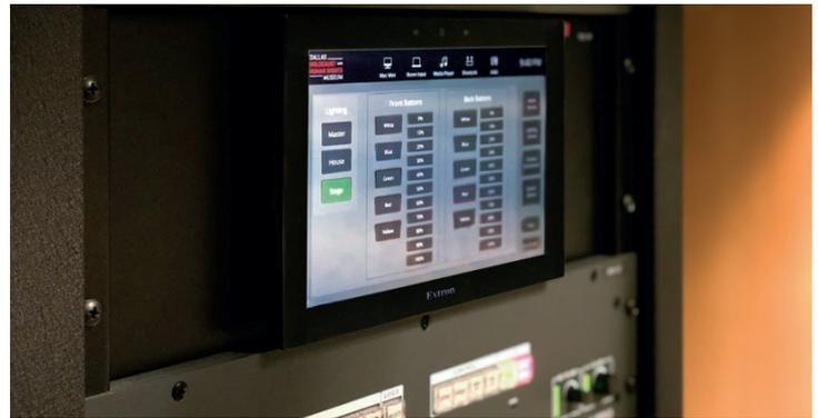
Das Herz des AV-Systems, die DTP CrossPoint 108 4K 10x8-Präsentationskreuzschiene, wurde zusammen mit anderen Systemkomponenten in einem Rack im benachbarten Technikraum montiert. Durch die kompakte Größe und Energieeffizienz der verschiedenen Extron-Produkte, wie z. B. des IPCP Pro 250-Steuerungsprozessors und SMD 202-Decoders für Medien-Streaming, passten die Geräte in ein Hauptrack. Die Nutzer können das System mit den TouchLink Pro-Touchpanels am Geräterack und dem Haupt-Bedienpult steuern.
