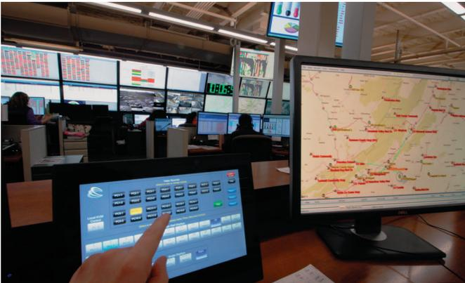
Die CTaC-Manager nutzen das Extron TLP Pro 1220TG TouchLink Pro-Touchpanel auf ihrem Tisch zur einfachen Steuerung des XTP-Systems und Auswahl der Inhalte für jedes der 28 wandmontierten Displays.
