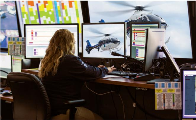
Das XTP-System erlaubt die Übertragung von Quellsignalen in jeder möglichen Kombination an die 28 Flachbildschirme, die an einer Längswand des rechteckigen Raumes angebracht sind. Die XTP-Empfänger werden über das CATx-Kabel von der XTP II CrossPoint 6400 aus ferngespeist.
