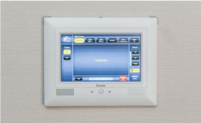
Die Extron DTP CrossPoint 84 4K IPCP MA 70-Kreuzschiene des Konferenzraumes wird durch das an der Wand montierte TLP Pro 720M-Touchpanel oder ein autorisiertes iPad mit installierter Extron Control App gesteuert. Das DTP-System ist mit der XTP II CrossPoint 6400 verbunden und ermöglicht den Zugriff auf alle CTaC-Ressourcen.
